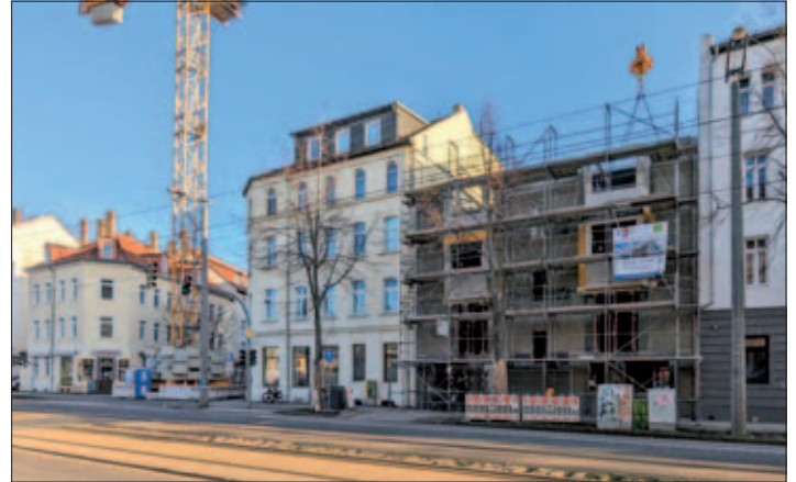
Aktueller Baufortschritt Delitzscher Straße 44, am 9. Januar 2024
