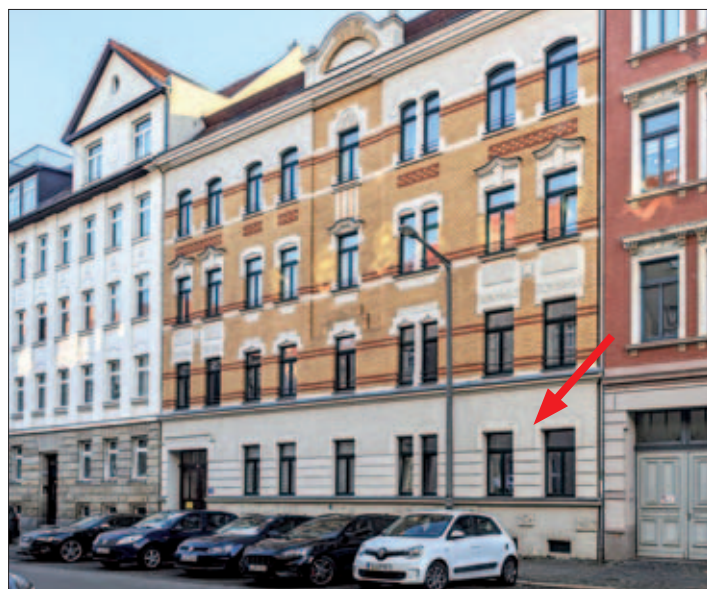
Die Schiebstraße 28, am 8. Januar 2024 (ehem. Bäckerei siehe Pfeil!)
