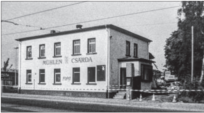
Die „Mühlen Csárda“ beim Abbruch, Juni 1992
